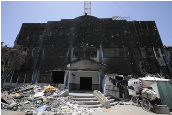
مركز صحي جباليا التابع للأونروا قبل وبعد تعرضه للقصف. الحقوق محفوظة للأونروا، 2024
